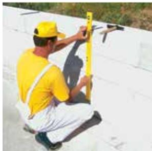
**1** В соответствии с проектом дома обозначаем на несущей стене место для будущей перегородки. Разметка должна быть строго перпендикулярна фундаменту.
