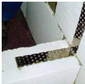
**6** Анкерка дополнительно возводимой перегородки. Гибкие связи крепятся к несущей кладке дюбелем. Для крепления перегородки к перекрытиям используются гибкие связи кладки или монтажная пена.
