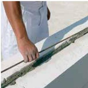
**7** Вкладываем в паз стальную стержень (арматуру), лучше всего — из профилированной стали диаметром не менее 6 мм.
