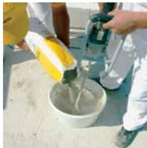
**4** Рекомендуется затворить водой сразу весь мешок раствора. Этого количества готовой смеси хватает для возведения приблизительно 1,5 м³ кладки газобетонных блоков.
