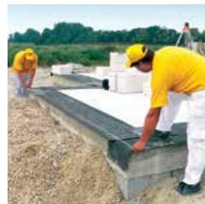
**2** Произведите точные обмеры контуров будущих наружных стен в соответствии с проектом!
