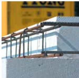
**1** В перекрытиях длиной **до 6 метров** для армирования монолитного пояса монтируем минимум 3 продольных стержня  $\varnothing 10$  мм. Диаметр проволоки для хомутов = 4,5 мм, расстояние между хомутами = 250 мм.
