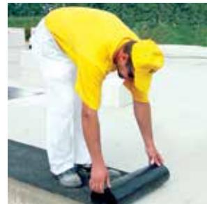
**1** Перед тем как приступить к кладке стен, следует выполнить гидроизоляцию фундамента. Очистите поверхность фундамента щеткой, уложите рулонный гидроизоляционный материал. Соединение полос производится с нахлестом не менее 150 мм.
