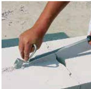
**2** При помощи ручного штробореза YTONG® в средней части кладки блоков делаем пазы, соответствующие длине арматуры.
