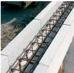
**8** Арматурные каркасы укладываются ближе к внутренней грани U-перемычки.
