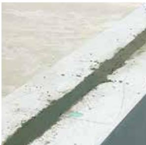
**8** После погружения стержня в цементный раствор полностью заполняем паз раствором, при необходимости удаляем мастерком его излишек. Выравниваем поверхность кладки, удаляем щёткой загрязнения и пыль.
