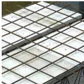
**5** После монтажа сборных элементов перекрытия на верхние стержни арматуры балок укладывается арматурная сетка 100x100x5 мм. Ее положение, высота установки и связь с верхней арматурой балки определяется проектом. Стыковка отдельных сеток между собой осуществляется с нахлестом шириной не менее 150 мм.
