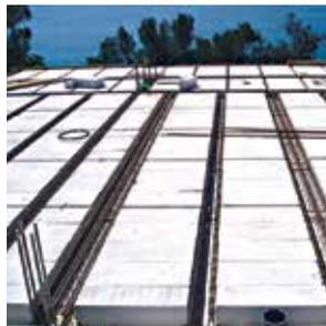
**4** Если толщина внутренних несущих стен меньше 25 см, не рекомендуется укладывать балки в одну линию. При большей толщине стены балки можно укладывать в одну линию.
