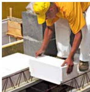
**1** Т-образные блоки YTONG® укладываются вручную **вдоль продольного направления балок**. Зазор между соседними блоками должен быть минимальным.
