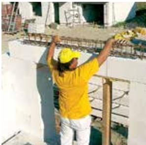
**7** Закладываем и фиксируем арматурные каркасы.
