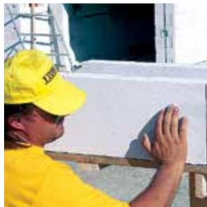
**5** Проверяем ровность кладки U-образных блоков YTONG®.
