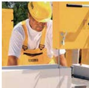
5 При строительстве многоэтажных домов для резки блоков рекомендуется использовать ленточную электропилу, которая обеспечит быстроту и безопасность резки. Блоки размещаются на передвижном столе пилы.
