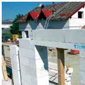
**18** Перемычки приобретают несущую способность после затвердевания раствора YTONG® для тонкошовной кладки. После затвердевания раствора поддержка монтажа может быть удалена.
