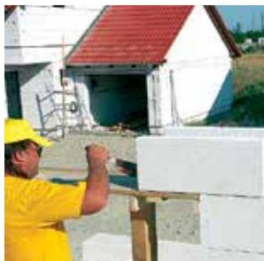
**3** U-образные блоки YTONG® укладываются на подготовленное основание так, чтобы глубина опирания перемычки составляла не менее 250 мм.
