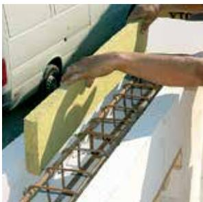
**9** Между внешней стенкой U-перемычки и арматурным каркасом вкладывается теплоизоляция.
