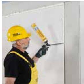
Места примыкания блоков YTONG® к перекрытиям или балкам каркасной конструкции заполняются монтажной пеной, благодаря чему стена приобретает дополнительную устойчивость.
