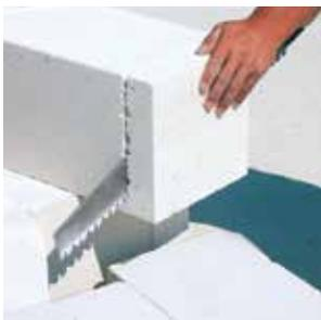
3 Чтобы распил получился более точным, необходимо отметить карандашом линию резки на двух сторонах блока — горизонтальной и вертикальной.
