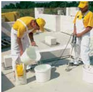
**1** Для подготовки раствора YTONG® для тонкошовной кладки требуются простые инструменты: электродрель с установленной перемешивающей лопастью, пластиковая емкость для размешивания раствора и вода.
