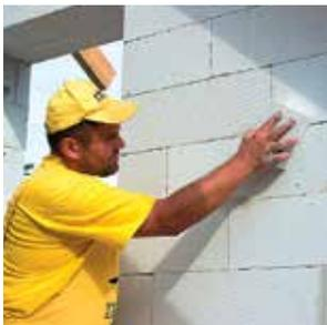
2 Избыток раствора удаляем после его затвердения при помощи куска блока YTONG®.
