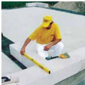
**2** Несущая внутренняя стена связывается с наружной стеной кладкой при помощи перевязки. Первый ряд блоков кладется на цементно-песчаный раствор толщиной не менее 20 мм. При этом необходимо постоянно проверять совпадение уровней стен по горизонтали.
