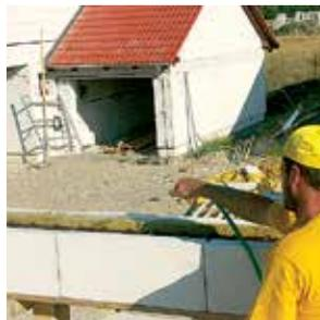
**11** Перед началом бетонирования смачиваем водой U-перемычку.
