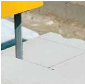
1 При подготовке ниш сначала помечаем на блоках размеры выреза.
