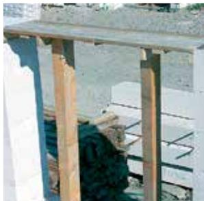
**2** U-образные блоки YTONG® укладываются на подготовленное горизонтальное основание. Эту функцию отлично выполняет доска или брус. Основание должно иметь надежную опору, чтобы во время заливки перемычка не прогибалась.
