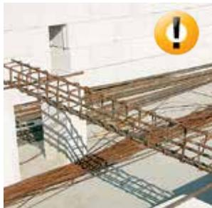
**1** U-образные блоки YTONG® являются элементами опалубки для железобетона. Железобетонная часть должна иметь соответствующее проведенным расчетам армирование. Для армирования лучше всего подходит пространственный арматурный каркас.
