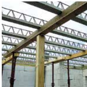
**2** При отсутствии инвентарных телескопических стоек допускается использовать деревянные монтажные опоры в виде столбов диаметром 140-160 мм или брусков. Профильные металлические трубы допускается заменять подпорными рейками из досок сечением не менее 50x120 мм (или бруски размером не менее 100x100 мм), установленными горизонтально ребром вверх и закрепленными на опорных столбах или инвентарных телескопических стойках.
