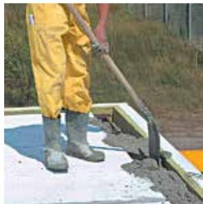
**3** Уплотняем бетон штыкованием или утрамбовываем с помощью вибратора.
