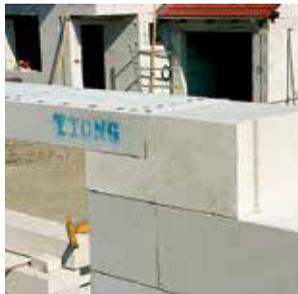
**13** Также перемычка может быть уложена на блоки с предварительным выпилom. Глубина опирания не менее 250 мм.
