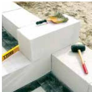
**5** Деталь связки внутренней и наружной стен. При кладке используется инструмент YTONG®.
