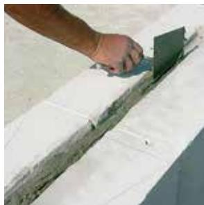
**6** Заполняем цементным раствором подготовленный паз до половины глубины. Для этого можно использовать и раствор YTONG® для тонкошовной кладки блоков.
