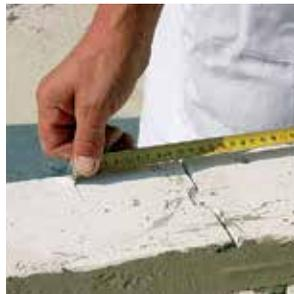
**10** Приступаем к кладке очередного ряда блоков, который будет находиться непосредственно под оконным проемом. При этом необходимо следить за перевязкой блоков минимум на 10 см.
