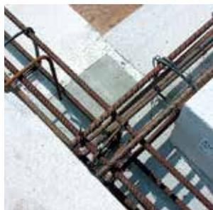
**2** Монолитный пояс укладывается в уровне перекрытия и бетонируется одновременно с перекрытием. Продольную арматуру пояса необходимо последовательно связывать внахлест (длина нахлеста минимум 900 мм), также возможна сварка. Особо важной является стыковка арматуры в углах.
