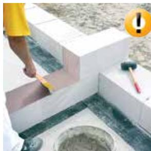
**6** Раствор также наносится на вертикальную поверхность блока.
