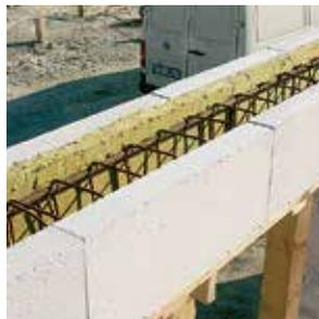
**10** Изображение подготовленной перед бетонированием перемычки из U-образных блоков YTONG®.
