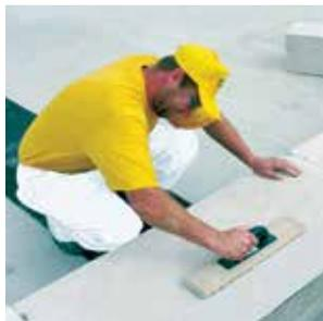
**1** Проверяем кладку в месте будущей стены; имеющиеся неровности устраняем рубанком. Тщательно очищаем поверхность кладки от пыли и загрязнений!
