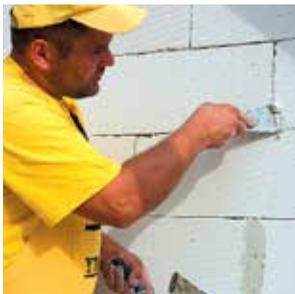
1 Образовавшиеся при кладке блоков щели или неровности заполняем раствором, который получаем при смешивании раствора для тонкошовной кладки YTONG® с пылью, оставшейся после резки блоков YTONG®, или специальным раствором, предназначенным для этой цели.
