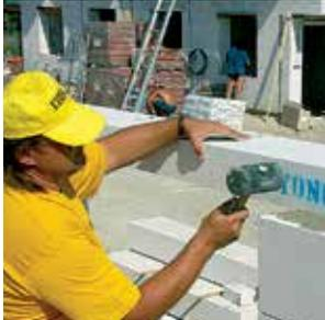
**7** Положение перемычки регулируется при помощи резинового молотка.
