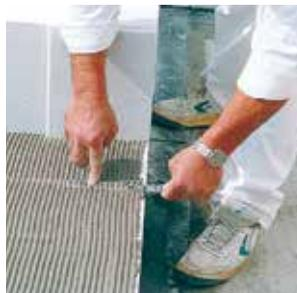
**5** Гибкие связи кладки можно монтировать в слой раствора и без гвоздей — путем вдавливания.
