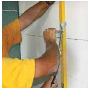
**4** При помощи штробореза очень просто изготавливать каналы для прокладки электропроводки и / или водоносной трубы.
