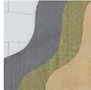
1 Штукатурки, использующие в своей технологии армирующую сетку, немного проигрывают по скорости, но позволяют предотвратить возможность возникновения мелких трещин
