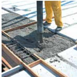
**4** Бетонирование перекрытия ведется захватками. Ширина захватки не менее 620 мм.
