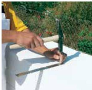
**2** В месте, где будет перегородка, в клеевой шов вкладывается гибкая связь из нержавеющей стали. Анкеры одним концом монтируются в несущую стену, а другим концом — в шов перегородки.
