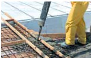
**2** Бетонирование монолитной части производится мелкозернистым (максимальная величина зерен — 10 мм) тяжелым бетоном классом не ниже В20 с использованием бетононасоса, крана с бадьей или тележек. При бетонировании следует избегать излишних концентрированных нагрузок, которые могут возникнуть при подаче большого количества бетонной смеси в одно место перекрытия.
