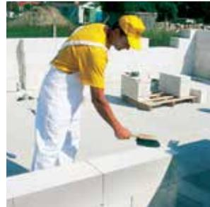
8 Имеющиеся неровности кладки устраняем при помощи шлифовальной доски или рубанка. Мелкие загрязнения и пыль удаляем щеткой.
