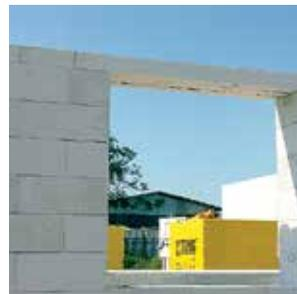
**12** Если перемычки укладываются на блоки со стандартной высотой, то для достижения требуемой высоты стены может потребоваться выравнивающий слой из блоков.
