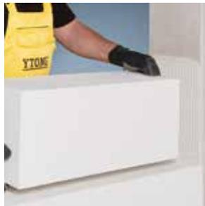
1 Часто однослойные стены из блоков YTONG® используются как заполнение железобетонного каркаса. При этом места примыкания блоков к железобетону заполняются цементно-песчаным раствором.
