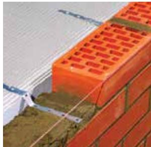
1 При строительстве многослойных стен кладка ограждающей стены (как правило, из кирпича) крепится к несущей стене из блоков YTONG® при помощи гибких анкеров. Анкеры выполняются из нержавеющей стали и устанавливаются из расчета в среднем не менее 5 шт. на 1 кв. м. Анкер размещается в шве между блоками YTONG® в процессе кладки стены, а затем, при возведении кирпичной стенки, отгибается и заводится в соответствующий шов кирпичной стены.
