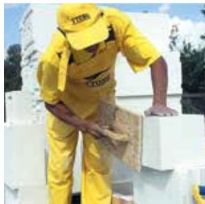
4 Чтобы получить гладкую поверхность и обеспечить хорошее сцепление раствора с блоком, поверхность блока выравниваем рубанком или шлифовальной доской.
