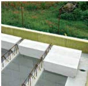
**3** Т-образные блоки первого (от стены) ряда сборно-монолитного перекрытия опираются одной стороной на балку, а другой на стену или ригель. Минимальная **зона опоры составляет 20 мм**. Размеры блоков перекрытия разрешается корректировать путем распиливания. Блок с обработанным линейным размером всегда укладывается только крайним поверх стены с выносом минимум 20 мм.
