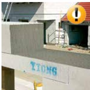
**15** Блоки укладываются на перемычку на раствор YTONG® для тонкошовной кладки. Вертикальные стыки при этом также осуществляются с применением тонкошовного раствора [вне зависимости от наличия системы «паз-гребень»].
