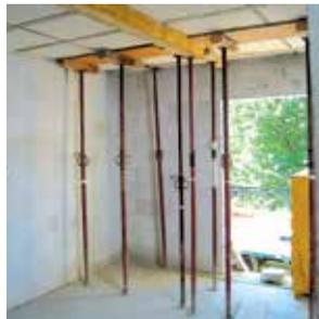
**1** Балки на время монтажа и бетонирования должны иметь промежуточные временные опоры — телескопические стойки и профильные трубы 80x40x3 мм в качестве подпорных реек. Несущая способность перекрытия, на которое передают нагрузку временные опоры, должна быть не менее 400 кг/м<sup>2</sup>.
