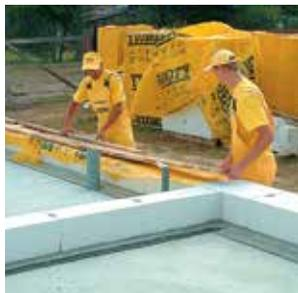
**2** Пленка может быть успешно использована для защиты сооружаемых стен от воздействия осадков.
