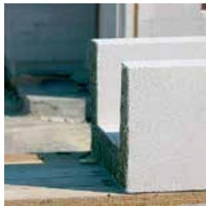
**4** Вертикальные швы между U-образными блоками заполняются раствором YTONG® для тонкошовной кладки блоков.
