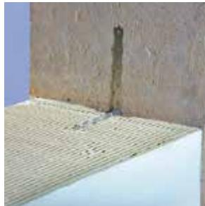
2 Соединение стены, заполняющей каркас, с ж/б колонной или перпендикулярной ж/б стеной выполняется при помощи металлических связей, располагаемых через каждые 2-3 слоя блоков YTONG®. При этом одна часть связи помещается в шве кладки из блоков и крепится специальными гвоздями, а вторая часть крепится к боковой поверхности столба или стены.
