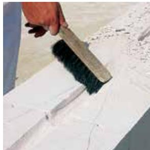
**4** Тщательно удаляем пыль, которая образовалась при вырезке пазов. Благодаря этому раствор будет иметь лучшее сцепление с блоками.
