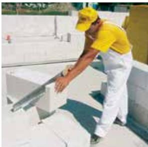
2 При строительстве частных домов резку блоков YTONG® проще всего осуществлять ручной ножовкой YTONG®.
