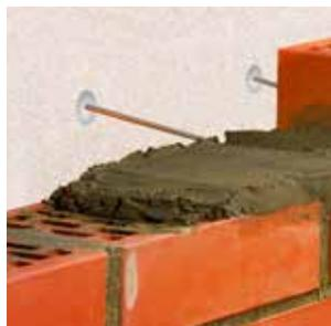
2 Крепление ограждающей кирпичной кладки к стене из газобетонных блоков YTONG® осуществляется при помощи специальных анкеров с передвижными шайбами, способными отводить конденсат.
