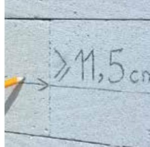
7 Длина крайних блоков, например, на краях (дверных и оконных) проемов или углов здания должна быть  $\geq 11,5$  см.
