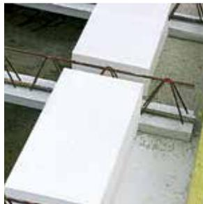
**2** Первый и последний блоки перекрытия между двумя балками должны быть подогнаны к внутреннему краю опорной стены. Возможен вынос блока на стену при соблюдении достаточной ширины и армирования монолитного пояса, определенных проектом.
